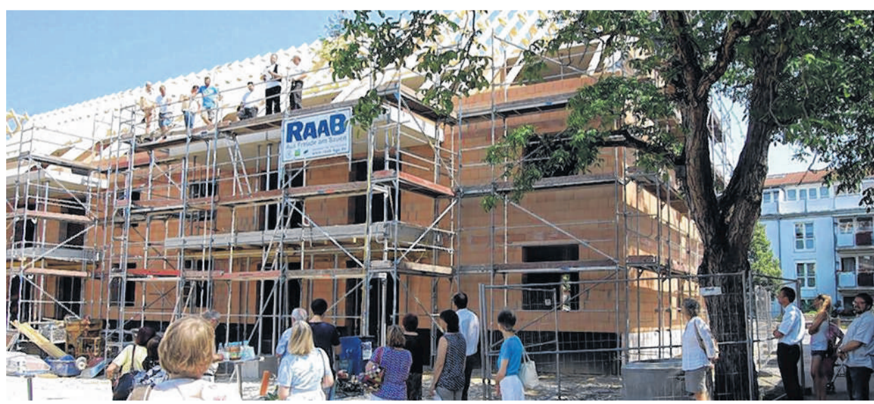
Baufortschritt: Zimmermeister Hannes Zimmerer sprach den Richtspruch für das Projekt „In der Heimat wohnen“ in Bad Staffelstein. FOTO: ANDREAS WELZ
