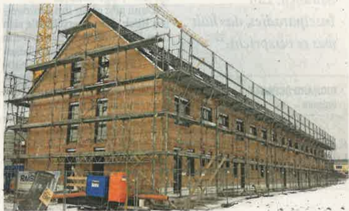
Mehrfamilienwohnhaus in Ziegelbauweise. Die Energieeffizienz ist hier noch besser als bei einem Einfamilienhaus. Fotos: Raab-Bau
