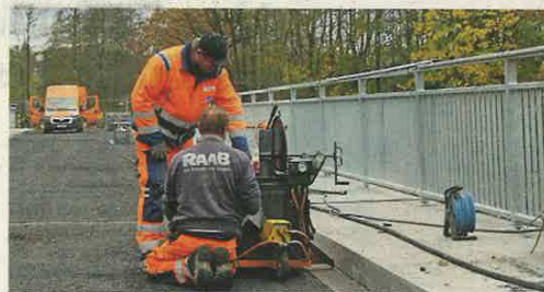
Bei der Mainbrücke werden nur noch Restarbeiten erledigt.
