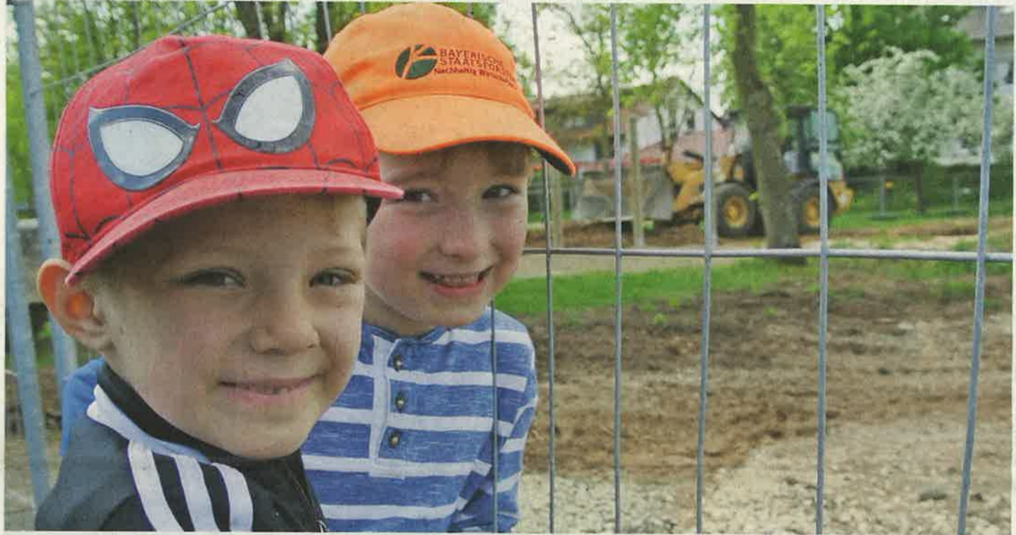
Die „Füchse“ Marius und Joris sind gespannt, was jetzt passiert. Ob ein Schaufelbagger den ersten Erdaushub macht?
