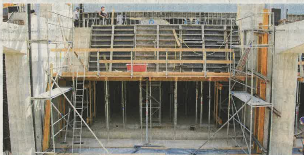
Der Zulauf zu den vier Turbinen ist bereits erneuert worden.
