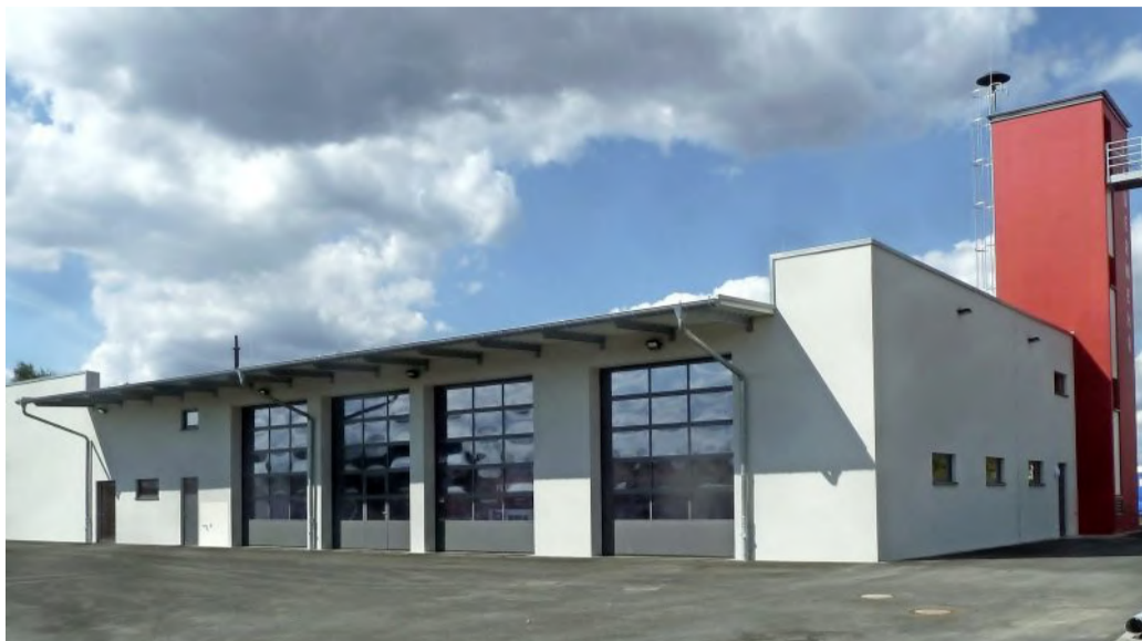
Das moderne Feuerwehr-Gerätehaus bietet viel neuen Raum für alle.
