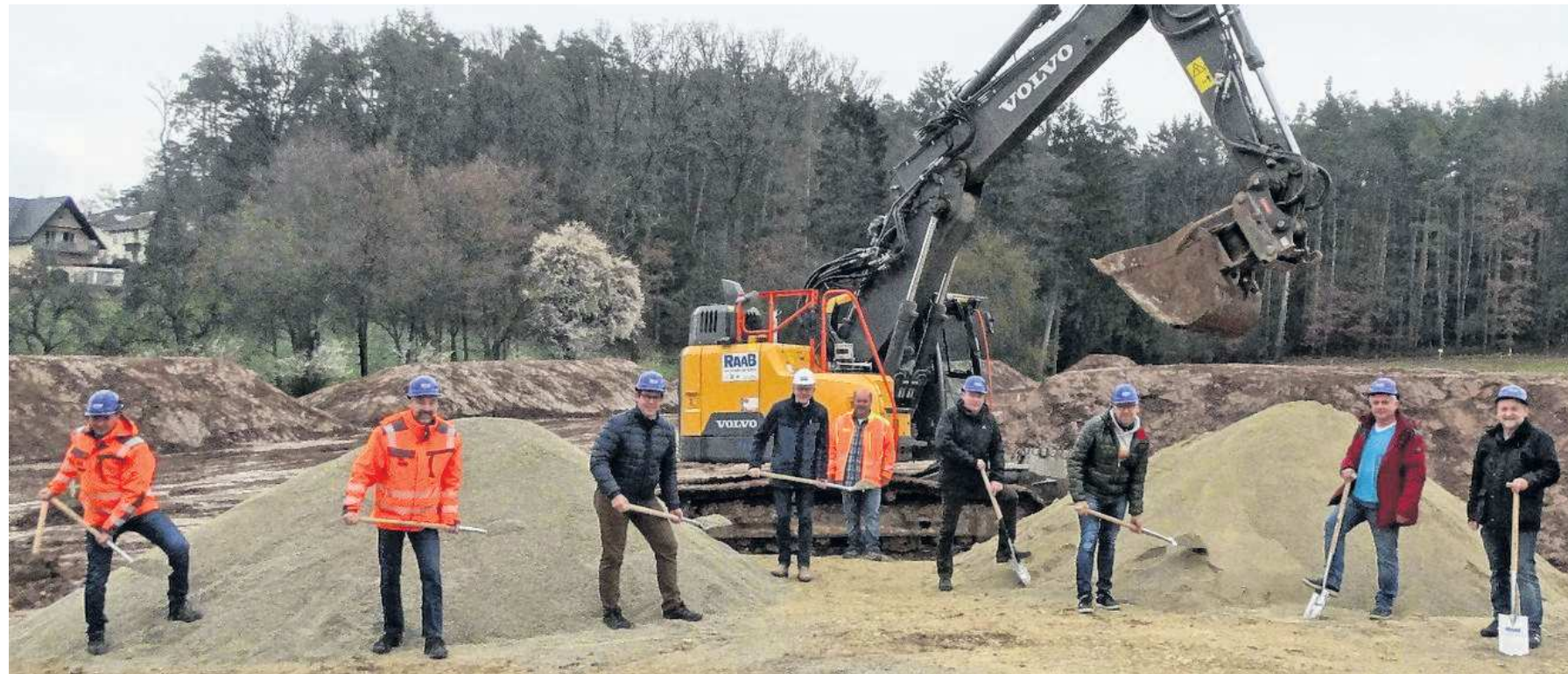
Die an der Erschließung Beteiligten sowie Gemeinderäte vollzogen mit Bürgermeister Jürgen Gäbelein (dritter v. li.) den offiziellen Spatenstich des neuen Baugebietes „Steinachblick“.
