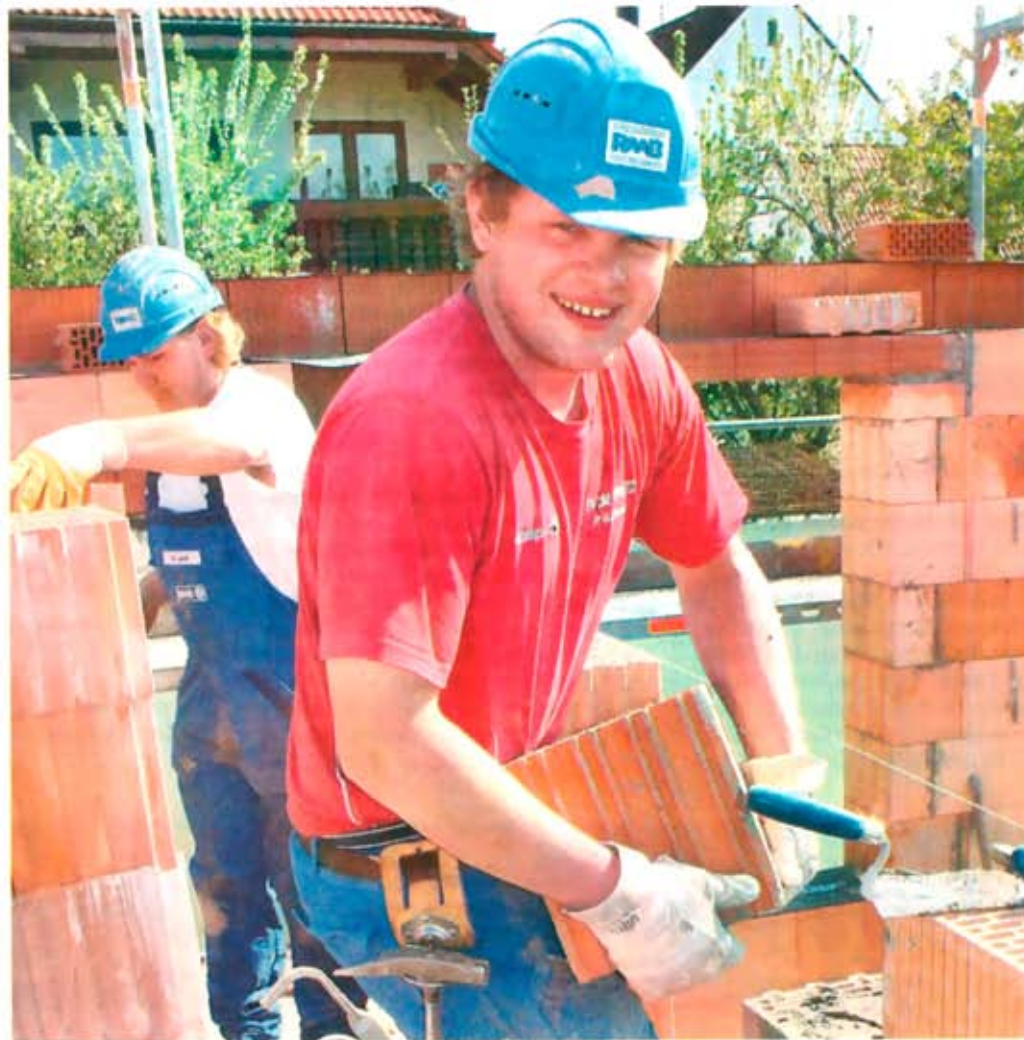
Peter Büttner setzt einen Stein auf eine Innenmauer. In Schönbrunn bauen Lehrlinge der Firma Raab in eigener Verantwortung ein Einfamilienhaus. Foto: Tobias Kindermann
