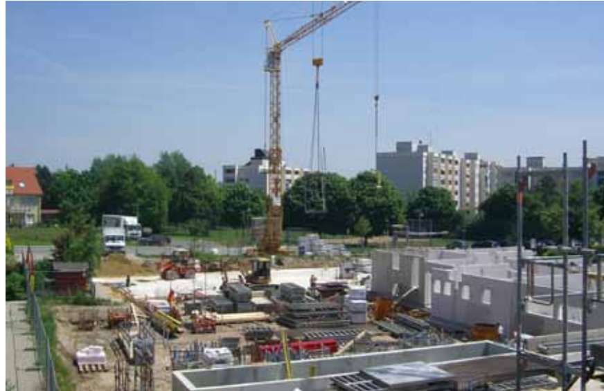
Fleißige Handwerker. Die Baustelle in Oberasbach im Juni 2010.
