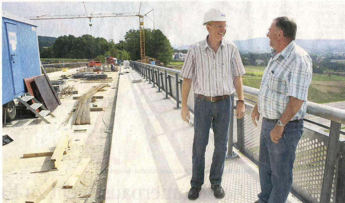
Wolfgang Schubert-Raab (links) und Heinrich Scherer, Leiter des Kreisbauhofes, stehen auf der Brücke bei Kösten und sprechen über den Bau- fortschritt des Projektes und die neue Umgehungsstraße LIF 2.
