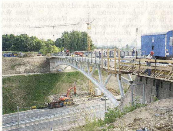
Die Fundamente der Lasttürme wurden beseitigt.
