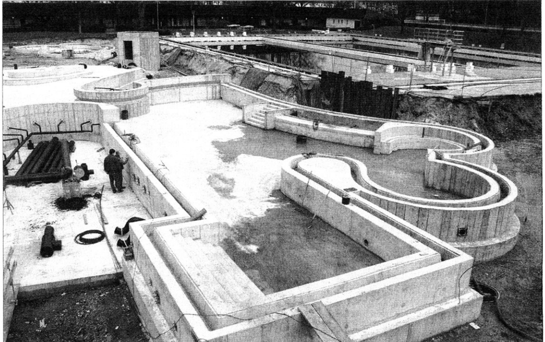
Ungewöhnliche Formen weist das künftige Erlebnisbecken im Stadionbad mit direkter Anbindung zum Wellenbecken (links) auf. Im Hintergrund sind gut die beiden alten Pools zu erkennen, die heuer letztmals in Betrieb sein werden. FT-Foto: Ronald Rinklef
