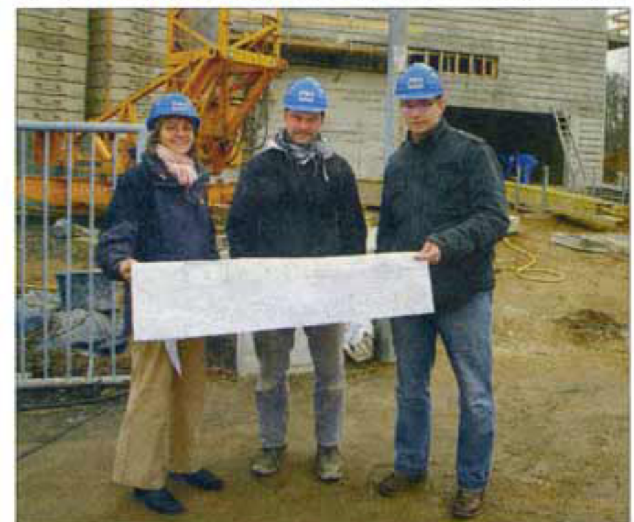
Nicht nur im Büro, sondern auch auf Baustellen (hier auf der „Hauptkampfbahn“, der Spielstätte von Eintracht Bamberg) ist die 42-jährige regelmäßig anzutreffen.
