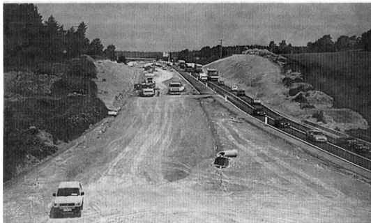
NÖRDLICHER BAUBEGINN, Verkehrsausleitung auf best. B 15 (A 93, Schönwald, Los 22).
