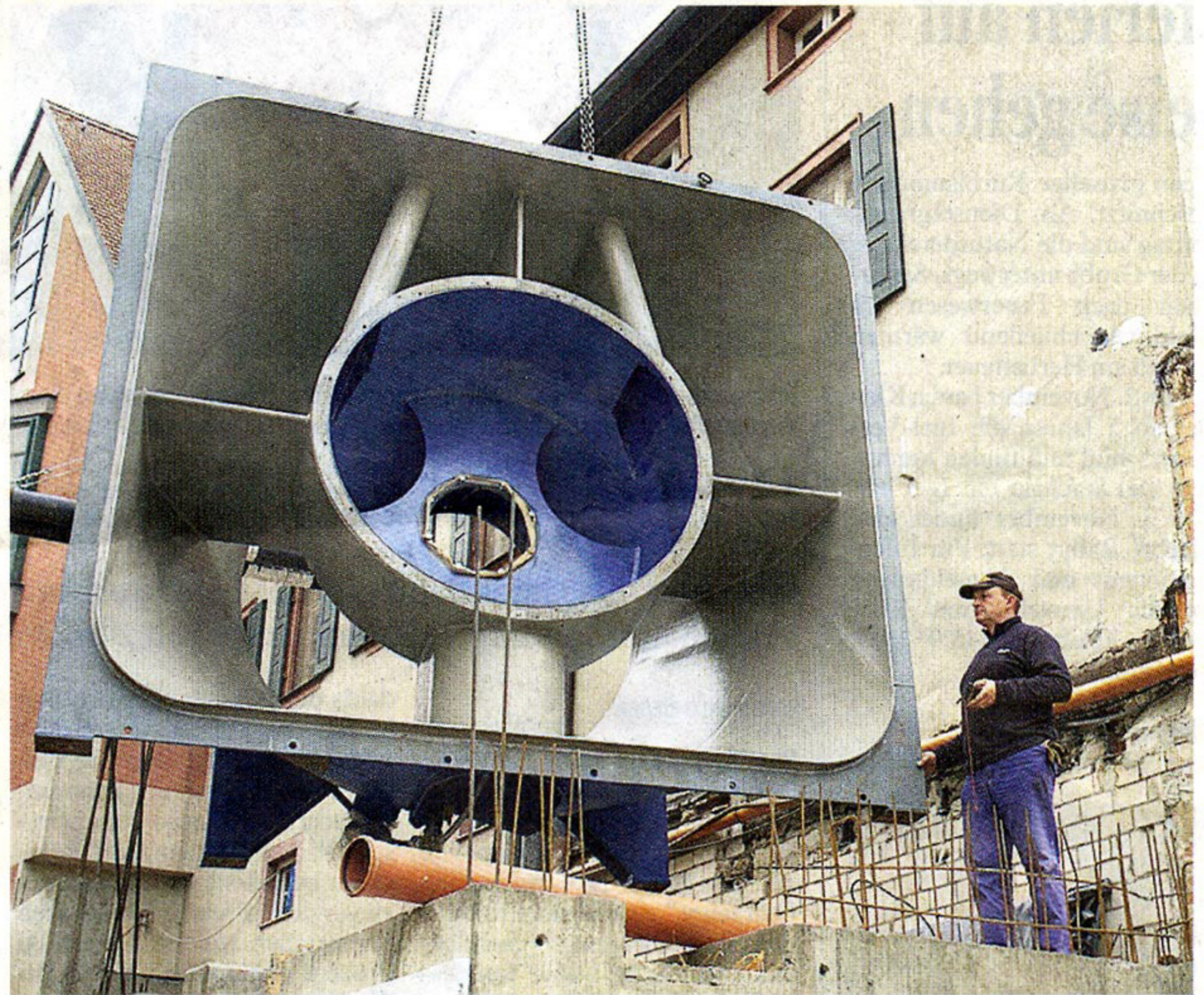
Das erste Stück war das Schwerste: Vier Tonnen wiegt dieses Turbinenteil, das gestern vormittag über die Steinmühle schwebte.
