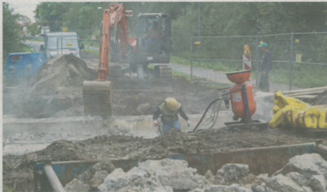
Damit beim Neuaufbau der Brücke eine gute Verbindung zwischen alten und neuen Brückenteilen besteht, wird der bestehende Unterbau aufwändig im Sandstrahlverfahren bearbeitet
