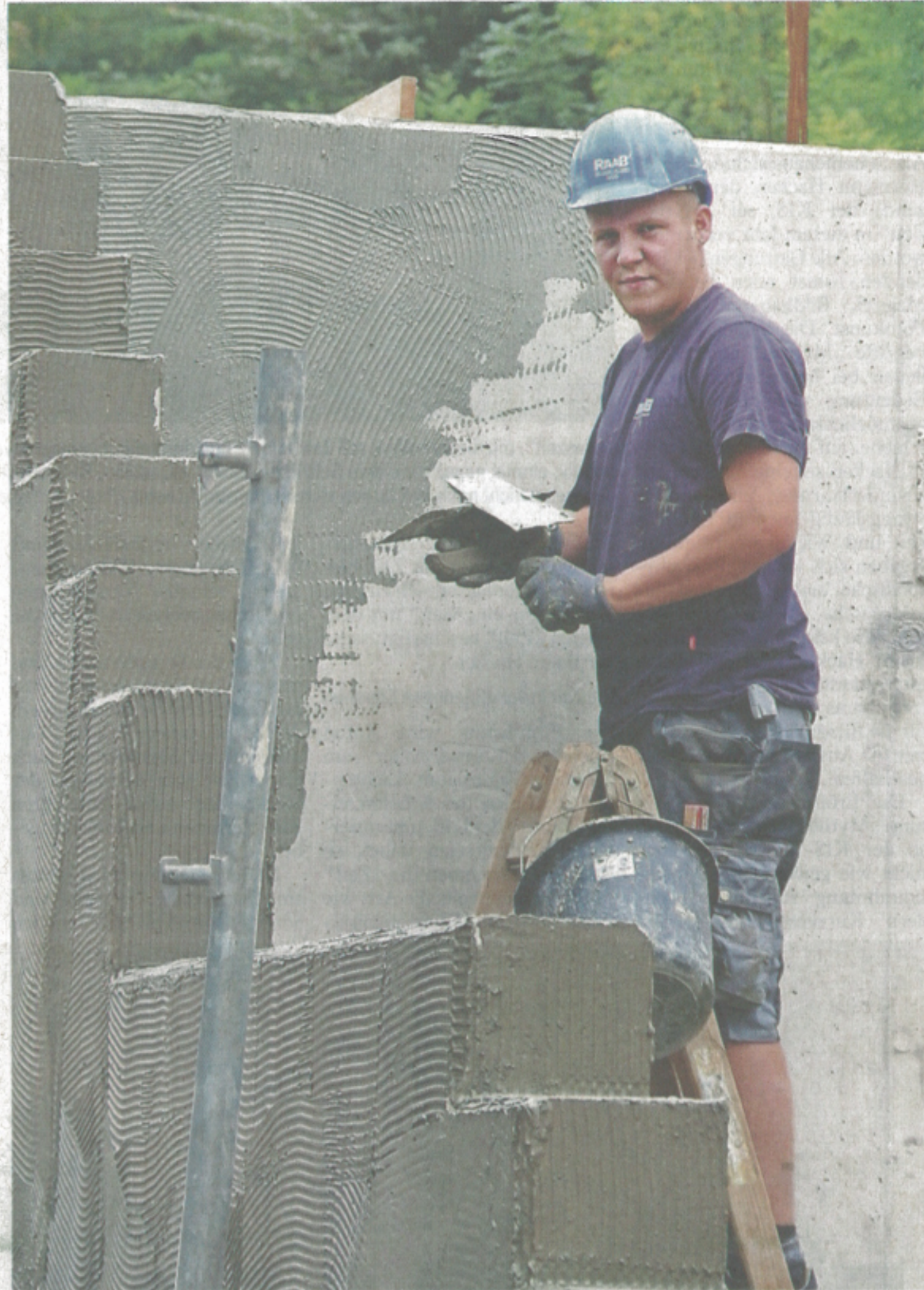
Maximilian Schick arbeitet gerade an der Bauwerksabdichtung einer neuen Tiefgarage für ein Studentenwohnheim in Coburg.
